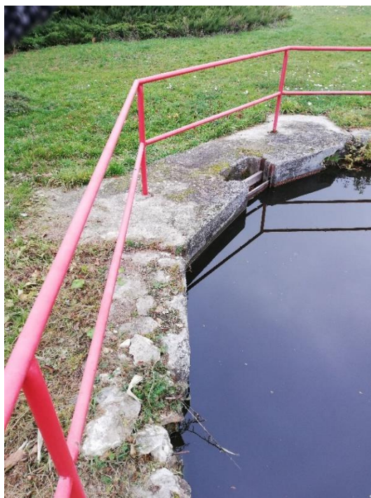
Obr. 5 Detailní pohled na porušenou stěnu hráze
