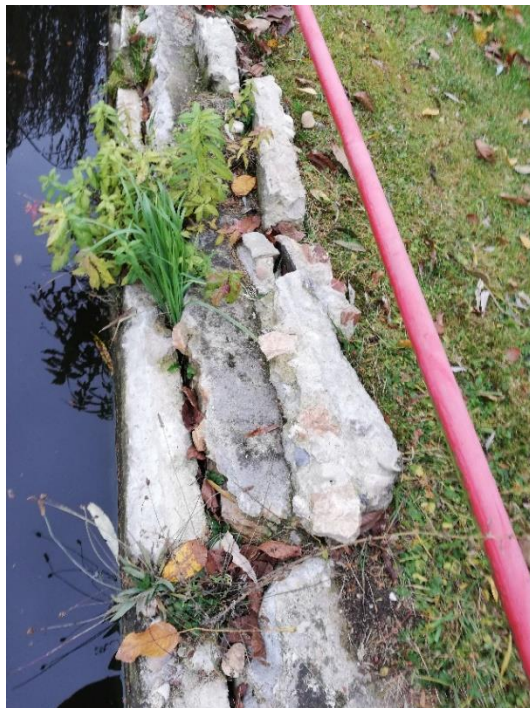
Obr. 5 Detailní pohled na porušenou stěnu hráze
