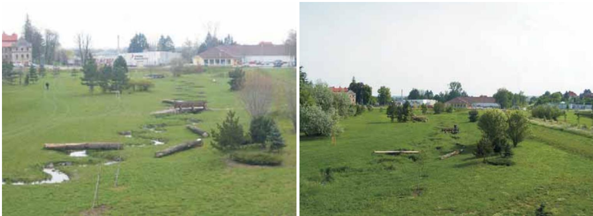
Obr. Suchá nádrž pod rybníkem Šibeňák na Valdickém potoce v Jičíně. Potok protéká v revitalizačních parametrech zátopy nádrže. V ploše zátopy vznikla parková úprava s podporou pobytové funkce. Odtok z nádrže pokračuje rovnou do zatrubnění, což je analogické k území pod Račanským rybníkem.
