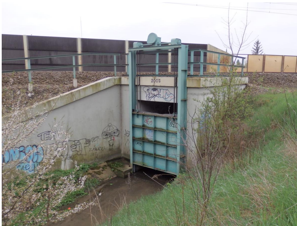
Obr. Stavidlový uzávěr na Švarcavě na dolním okraji mostu pod železničním koridorem. Je patrné, že při uzavření může voda přetékat nad horním okrajem.
