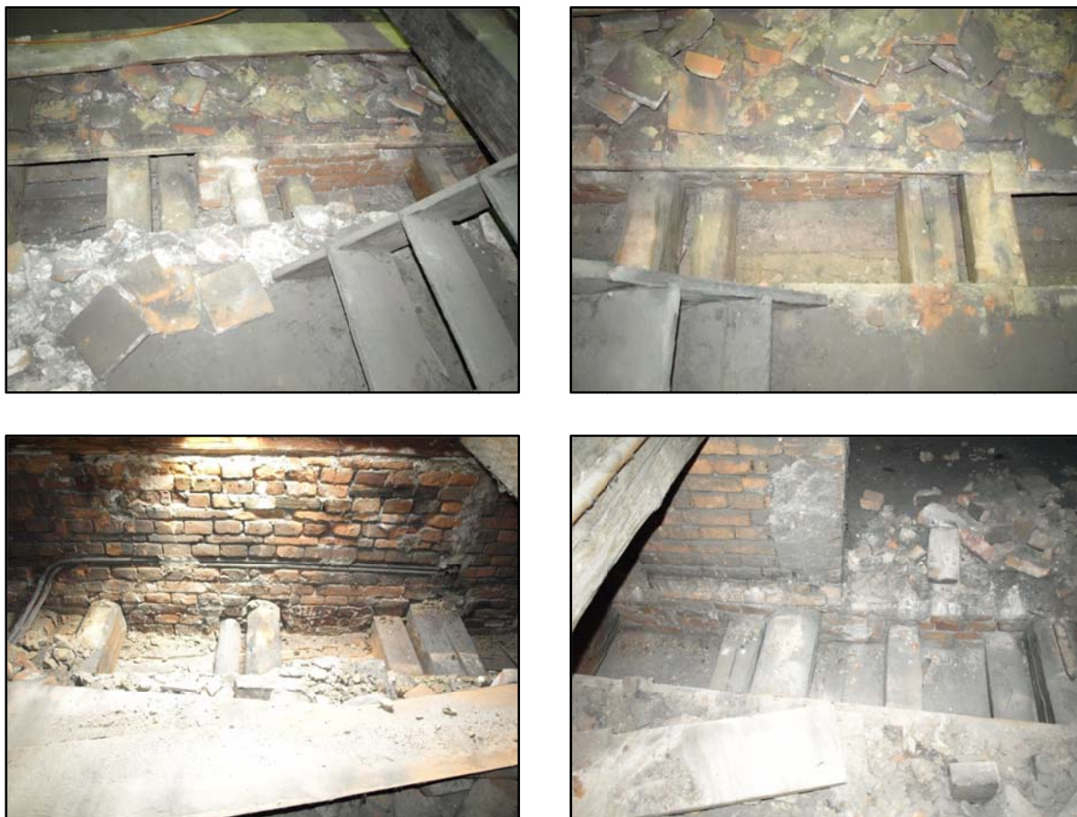
Obr. 1: Obnažené stropní trámy a rákosníky u objektu A (nahore) a objektu B (dole).
